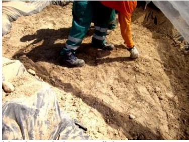
Limpieza de la superficie
