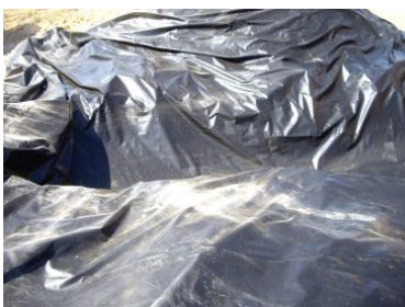
Revestimiento de zanja
