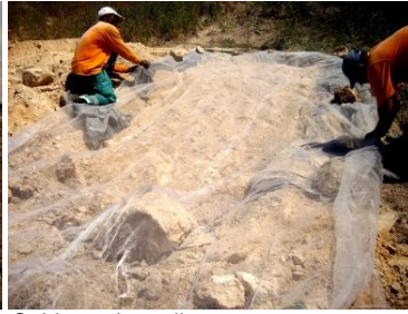
Cubierta de malla
