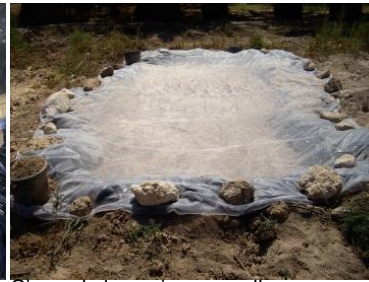
Cierre de la zanja con malla
