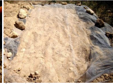
Cierre de la zanja con malla
