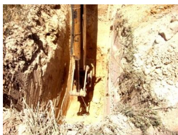
Abertura de la zanja
