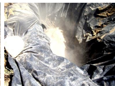
Tapado de la zanja
