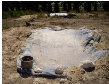
Cierre de la zanja con malla
