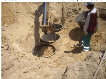
Rellenado de tierra
